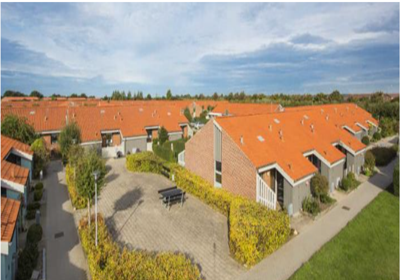
Beliggende: Fyrparken 98-162, 164-290, 6710 Esbjerg V
